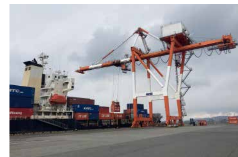
ガントリークレーン(和歌山下津港本港区)
